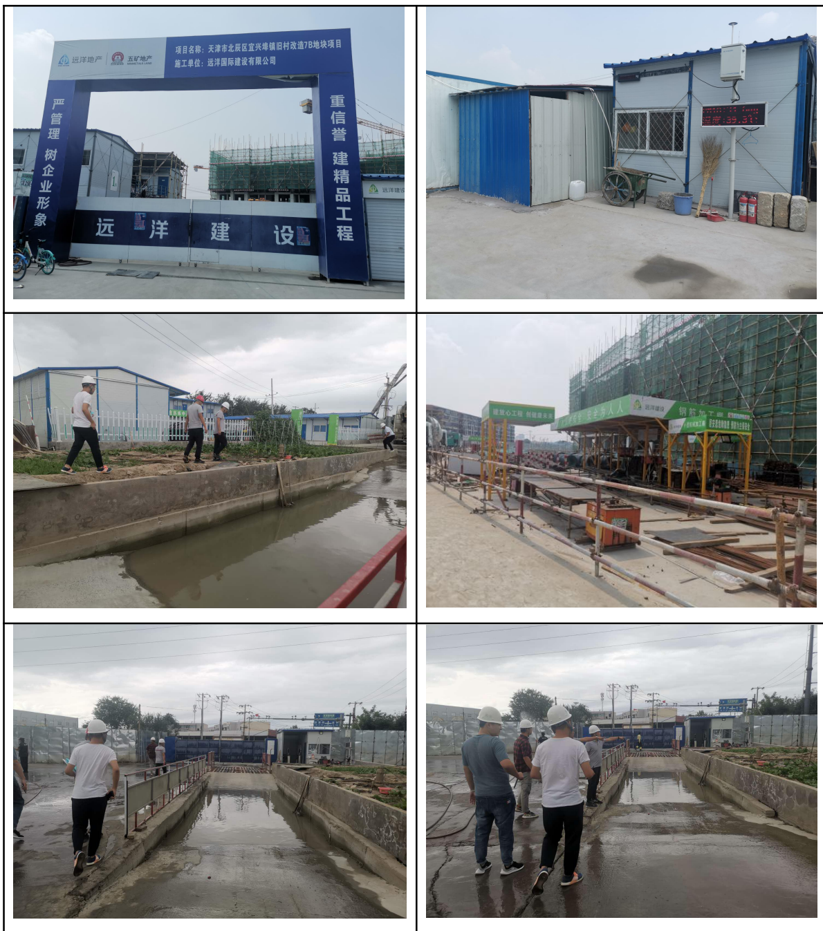
水土保持措施
