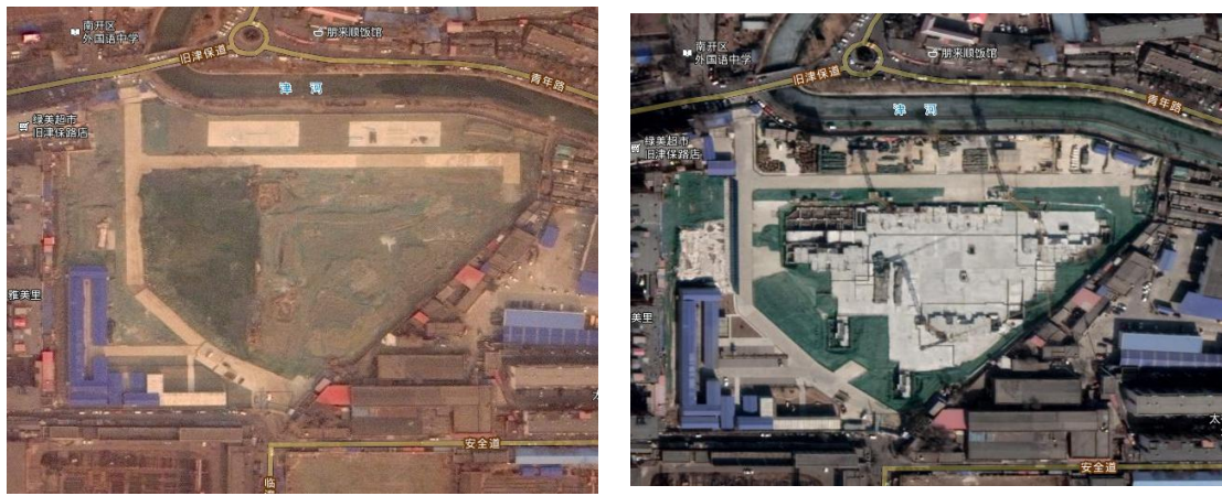
图 3-2 遥感影像卫星对比图（施工中 2017.1）
