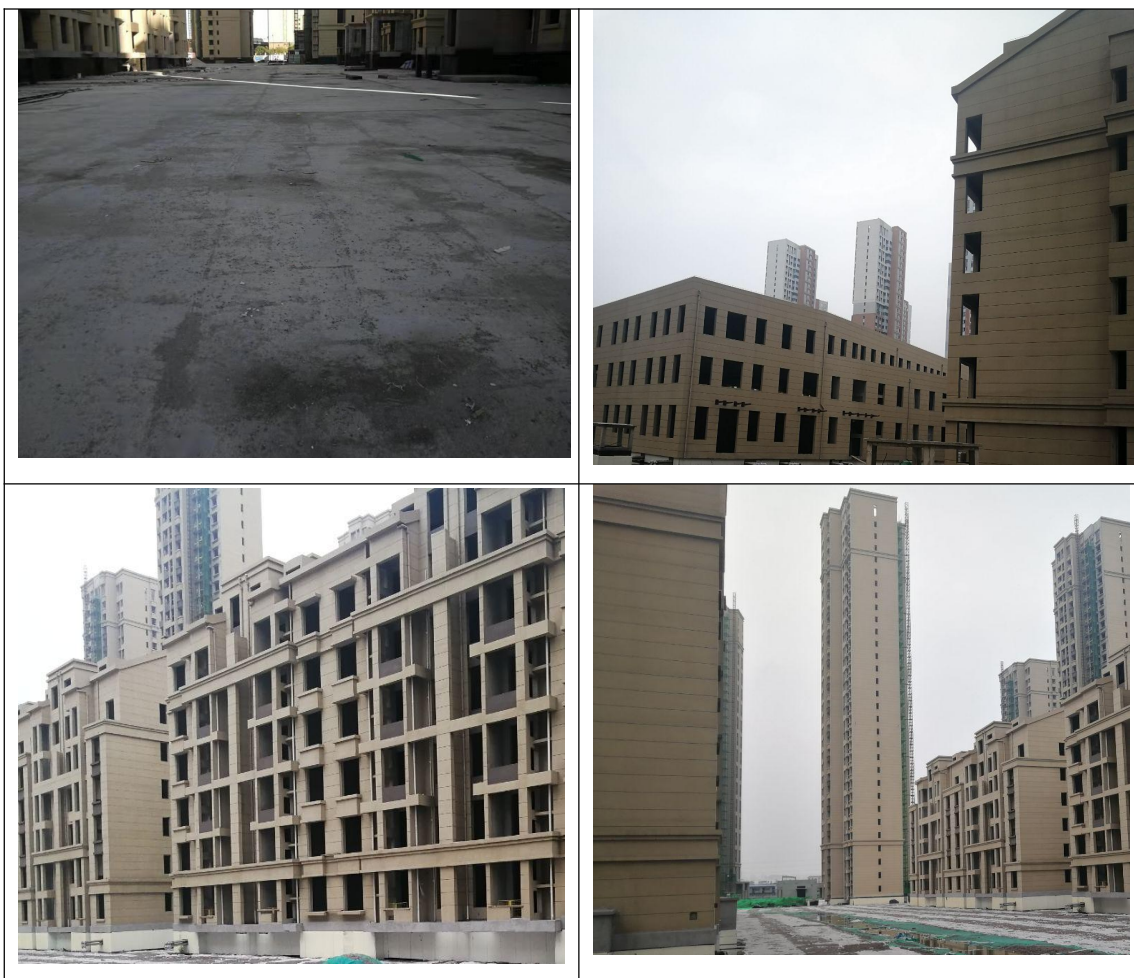
附图 4. 现场施工照片
