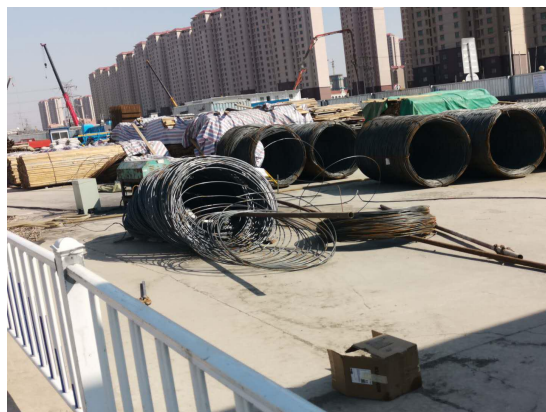
施工生产生活区
