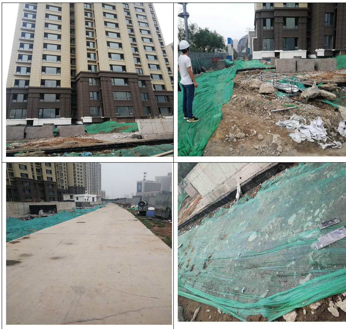
附图4. 现场施工照片图
