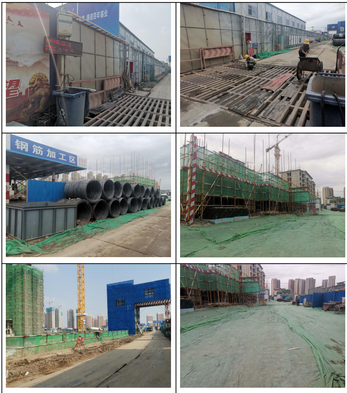
水土保持措施
