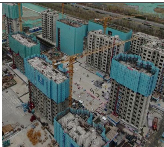
部分主体施工
