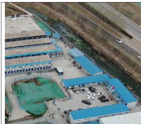
施工生产生活区
