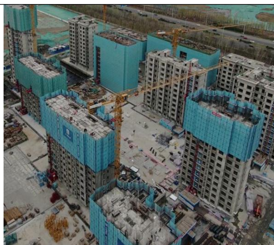
部分主体施工
