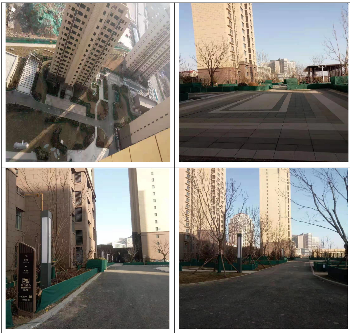
附图4. 现场施工照片图
