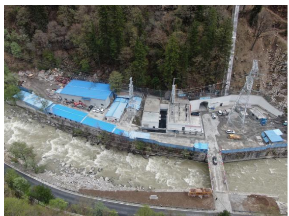
终点：剑科水电站
